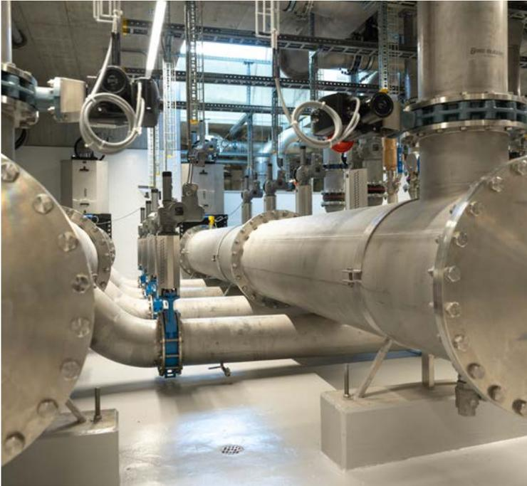
Die Installationsarbeiten im Pumpwerk konnten abgeschlossen werden. Die Ansaugung von Seewasser über die beiden Leitungen auf einer Tiefe von 20m resp. 30m und die Rückführung in die Zähl funktionieren einwandfrei.
