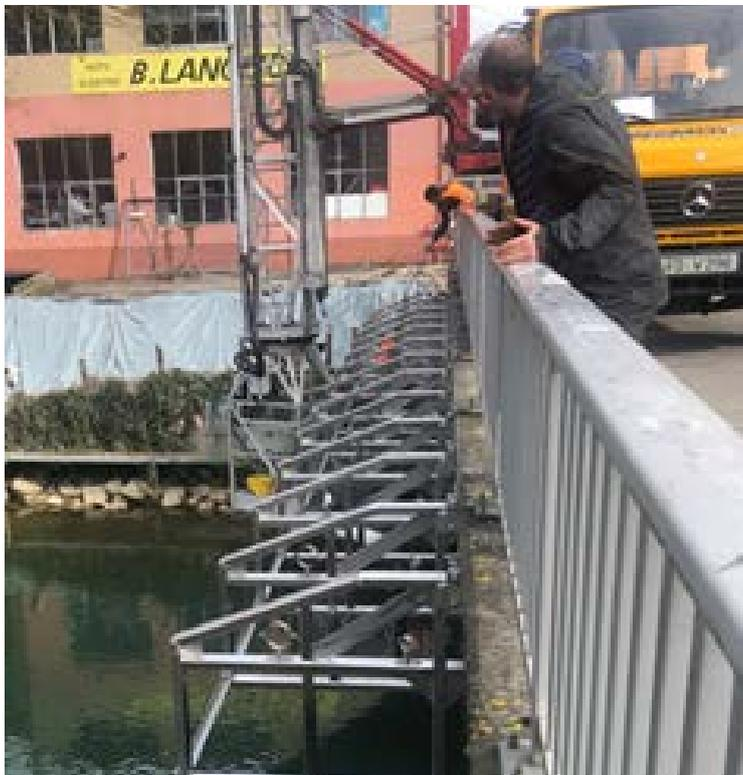
Für die Querung der Zihl wurden die Leitungen für die Lieferung von Wärme und Kälte in das Gebiet Biel an der Dr. Schneider-Brücke befestigt. Hierzu waren eigens entwickelte Träger nötig, welche von der Brücke her mit einem Spezialfahrzeug angebracht wurden.
