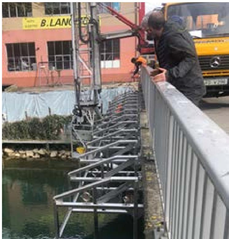
Pour traverser la Thielle, les conduites destinées à l’approvisionnement en chaleur et en froid de la région de Bienne ont été fixées au Pont Dr. Schneider. Pour ce faire, il a fallu mettre au point des supports spéciaux qui ont été installés depuis le pont à l’aide d’un véhicule spécial.
